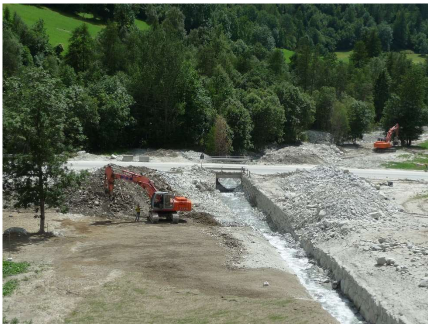
Figura 7 – La fotografia sopra ritrae il tratto di alveo di interesse oggetto di lavori di disalveo. Il sito dove verrà realizzata l'opera di presa interrata e la soglia di derivazione (freccia rossa) non è stato interessato dal recente fenomeno alluvionale del luglio 2015, rispetto al quale le fotografie sono immediatamente successive. La fotografia sotto indica gli effetti dello stesso fenomeno alluvionale nel tratto di alveo del torrente Baudier alla sua confluenza con il torrente Buthier. L'intervento in progetto non verrà realizzato in corrispondenza di questo tratto di conoide.
